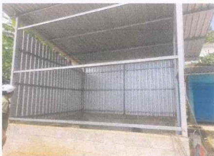
Foto 5: MEJORAMIENTO DE COCINA - CERRAMIENTO
