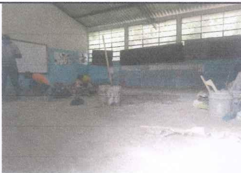
Foto 3: MEJORAMIENTO DE PISO DE CONCRETO A CERAMICO
