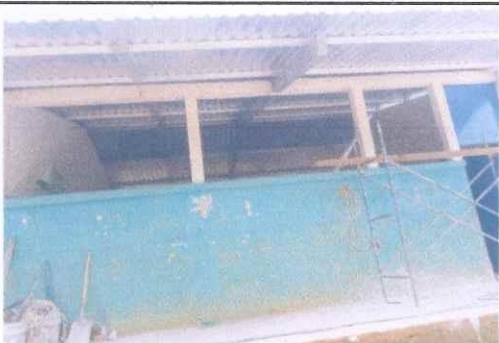
Foto 2: MEJORAMIENTO DE VENTANERIA FRONTAL
