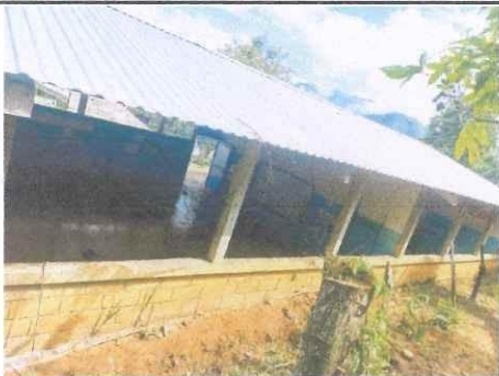
Foto1: MEJORAMIENTO DE VENTANERIA TRASERA
